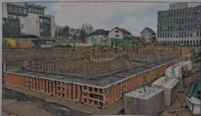
Das Kellergeschoss im neuen Baugebiet „Quartier Neumühle“ ist schon fertig. 2025 soll der Schulbetrieb aufgenommen werden. Foto: js
