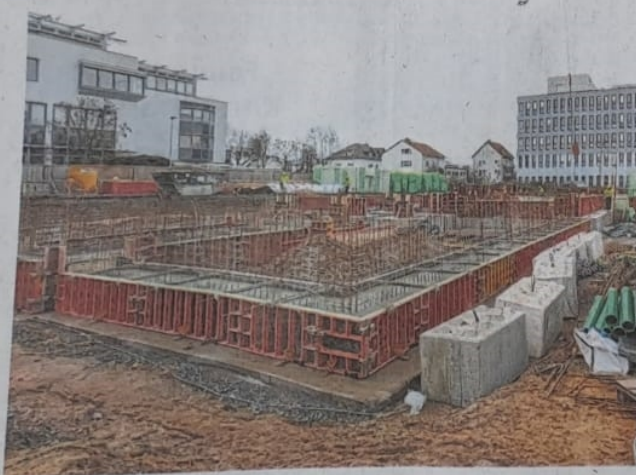
Das Fundament ist bereits gegossen.
